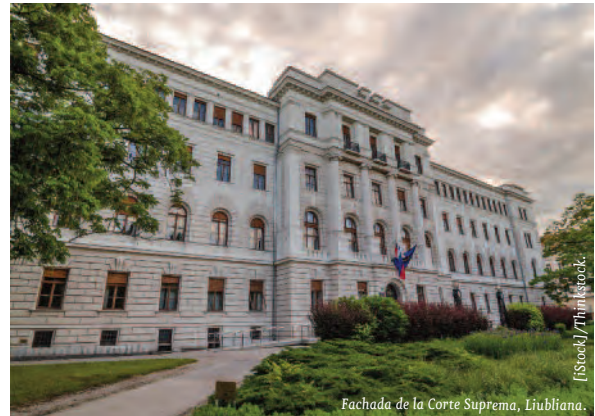
Fachada de la Corte Suprema, Liubliana.
